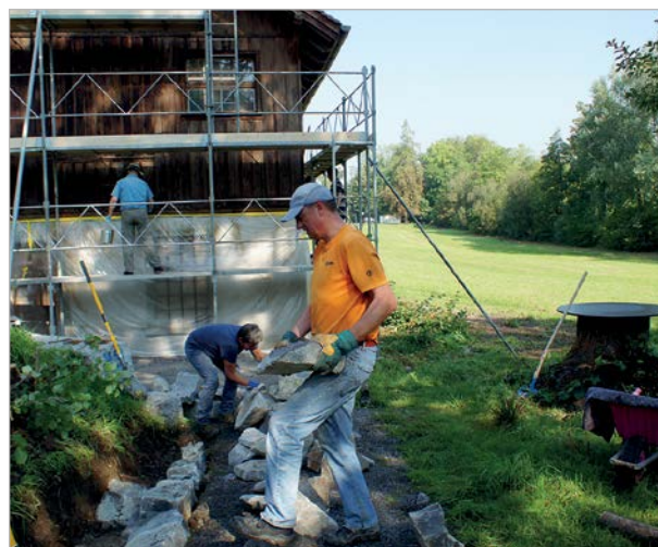
Das präzise Einpassen der Steine ist anstrengend.
