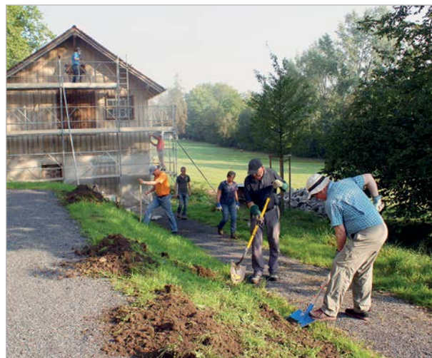
Vorbereitungsarbeit für eine 15 Meter lange Trockensteinmauer beim Kinderheim Hagendorn.
